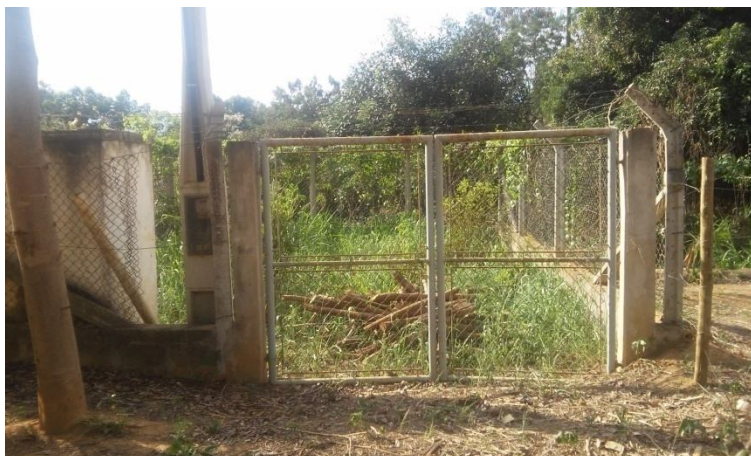
Foto 5 – Portão entrada da ETE – arquivo pessoal 07/10/2016
