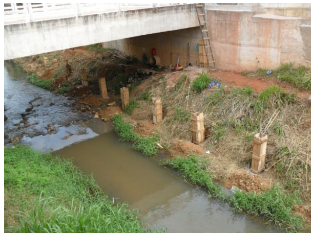
Foto 7 – Pilaretis executados no contrato 45/2012 para apoio de rede coletora de esgoto sanitário, aérea – arquivo pessoal 22/05/2012
