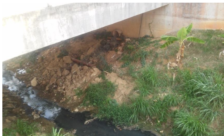
Foto 1 – Tubulação de esgoto fora dos pilares – arquivo pessoal 07/10/2016
