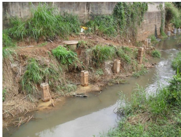
Foto 6 – Pilaretis executados no contrato 45/2012, para apoio da rede coletora de esgoto sanitário, aérea, - arquivo pessoal 19/07/2012
