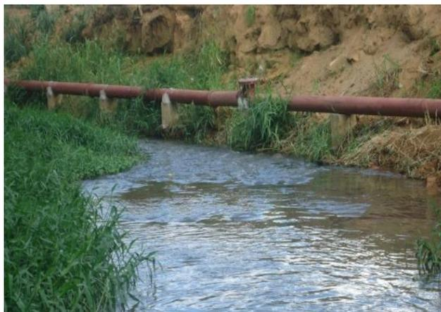
Foto 8 – Rede de coletora de esgoto sanitário, aérea, fixa em pilaretis no contrato 45/2012 - arquivo pessoal janeiro/2014
