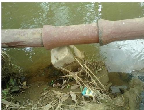
Foto 10 - Rede coletora deslocada dos pilaretis devido a força da correnteza – arquivo pessoal janeiro/2014
