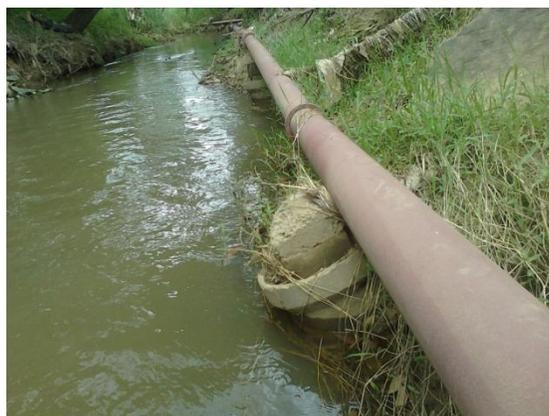
Foto 9 Rede coletora deslocada dos pilaretis devido a força da correnteza – arquivo pessoal janeiro/2014
