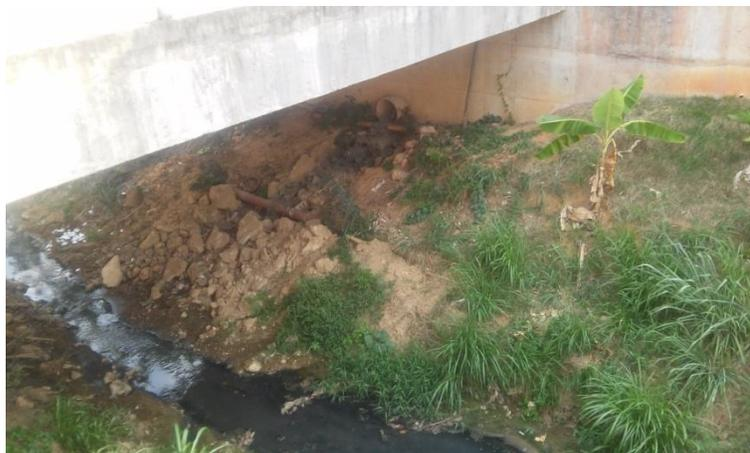
Foto 1 – Tubulação de esgoto fora do pilares – arquivo pessoal 07/10/2016
