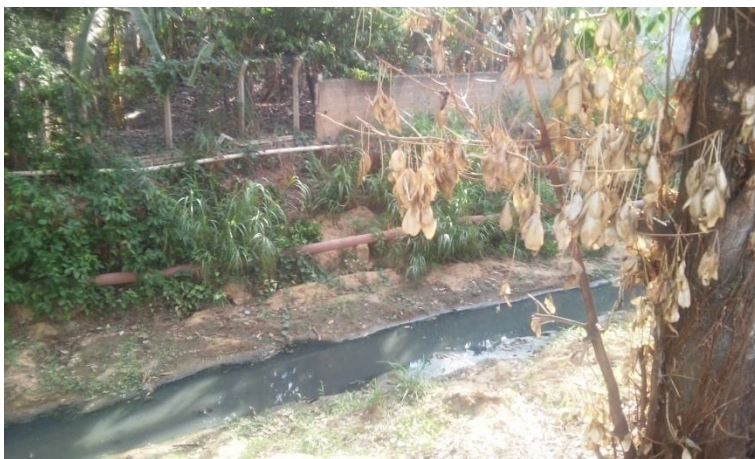
Foto 2 – Danos ao pilareti – tubulação de esgoto fora de nivelamento, devido a enchente – arquivo pessoal 07/10/2016
